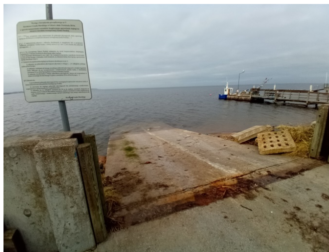
SLIP REWA nr 2 Slip w sąsiedztwie przystani rybackiej, 54^{\circ} 37' 55.0'' \text{ N } 18^{\circ} 29' 46.0'' \text{ E} (54,631934, 18,496354) Nadaje się do wodowania łódek do 7m długości. W całości wybetonowany. Dojazd od ul. Koralewej.
